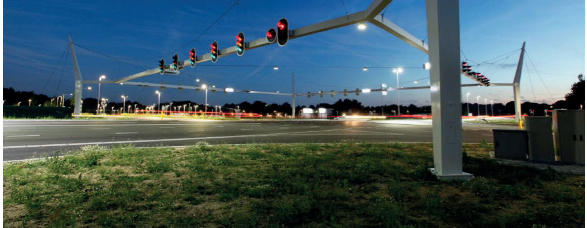
Figuur 5: Gemeente Nijmegen had de wens tot herinrichting van kruispunt Neerbosch, om daarmee ook de entree naar de stad, te accentueren. Ontwerpbureau ipv Delft ontwierp een multifunctionele poortconstructie die verlichting, bewegwijzering en verkeerslichten integreert in 'Poort Neerbosch' een opvallende maar ingetogen slanke staalconstructie. De kosten voor de multifunctionele poortconstructie kwamen overeen met de kosten van alleen de standaard portalen met verkeersregelinstallatie (VRI) Foto ipv Delft
