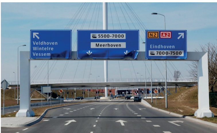
Figuur 6: Ontwerpbureau ipv Delft ontwierp voor de bewegwijzering portalen die ook de vereiste aanrijdbelasting voor de brug kunnen opvangen. Zo verplaatste de vereiste aanrijdbelasting van de brugconstructie naar de portalen van de bewegwijzering. Hiermee werd het mogelijk de brugconstructie van de Hovenring slanker uit te voeren en 1 miljoen euro aan staal te besparen. Foto ipv Delft
