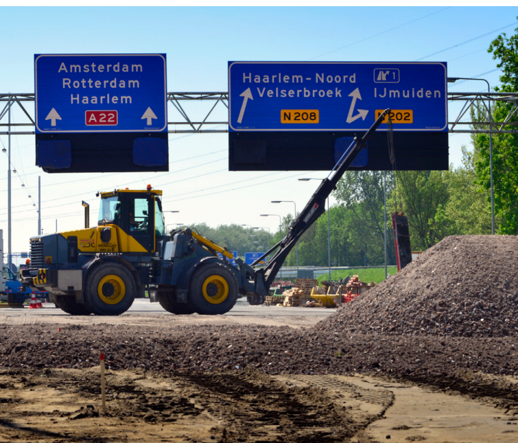
Werkzaamheden Velsertunnel noordkant
