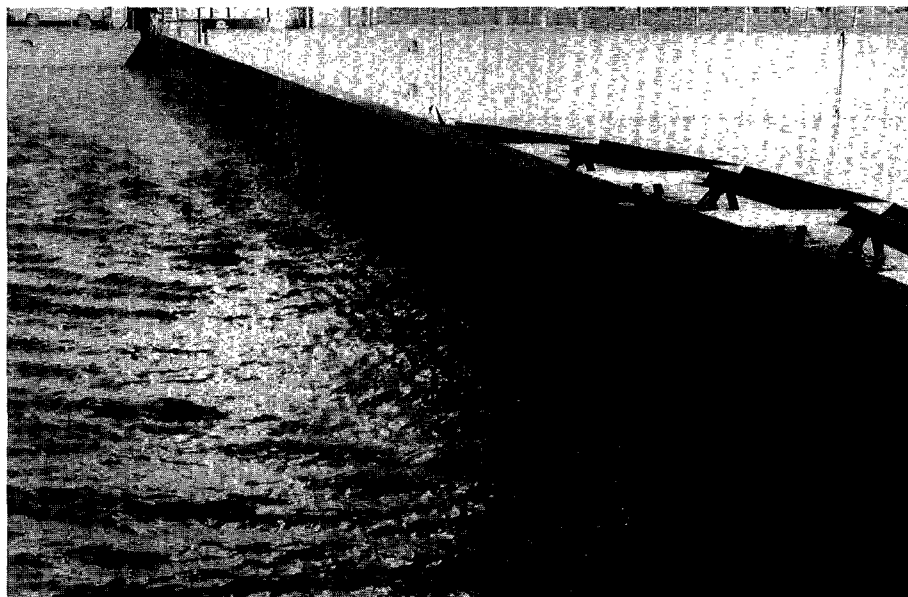
Figuur C1.1: Dwarsgolven aan de bovenstroomse zijde van de hefdeur in de keersluis te Ravenswaay, opgewekt door trillingen bij 'gesloten' deur.
