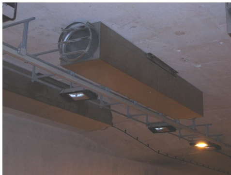
Figuur 4-7: Ventilatoren met afbuig-schoepen in een nis
