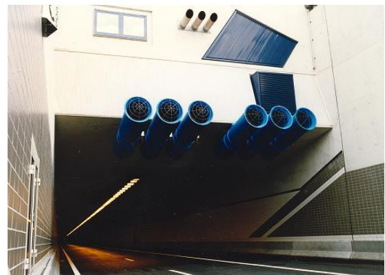
Figuur 4-3: Wijkertunnel (1996) – ingang zuidzijde (l) en ingangsv ventilatoren met inlaat in open lucht (r)
