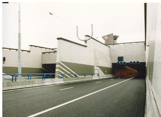
Figuur 4-3: Wijkertunnel (1996) – ingang zuidzijde (l) en ingangsv ventilatoren met inlaat in open lucht (r)
