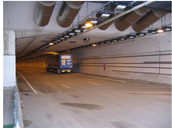
Figuur 4-1: Thomassentunnel (2004) – ingang met rode roosterconstructie (l) en ingangsv ventilatoren onder het rooster (r)
