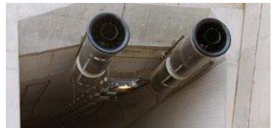
Figuur 4-1: Thomassentunnel (2004) – ingang met rode roosterconstructie (l) en ingangsv ventilatoren onder het rooster (r)
