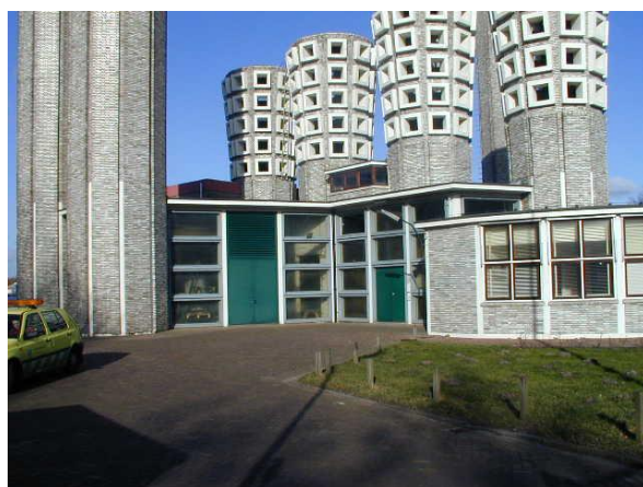
Figuur 2-15: Ventilatietorens van de dwarsventilatie in de Velsertunnel
