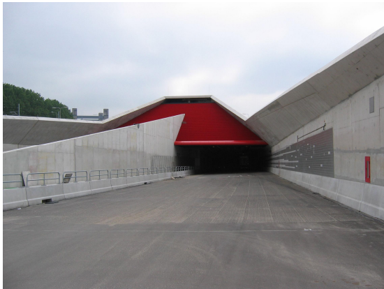
Figuur 4-1: Thomassentunnel (2004) – ingang met rode roosterconstructie (l) en ingangsv ventilatoren onder het rooster (r)
