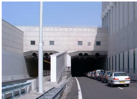
Figuur 4-2: Beneluxtunnel (2001) – ingang zuidzijde (l) en ingangsv ventilatoren met inlaat in open lucht (r)
