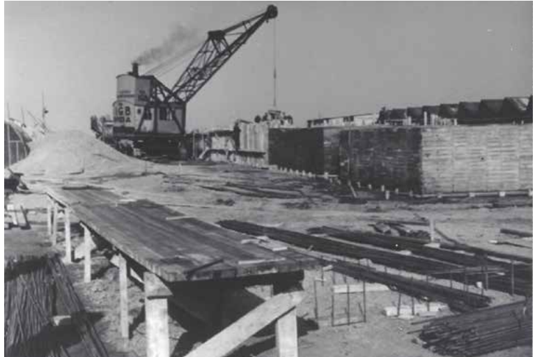
Bouw van caissons voor de Deltawerken in 1953.
