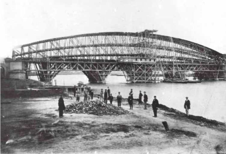
De bouw van de spoorbrug te Culemborg, 1866 – 1868. De tijdelijke steiger in de rivier bevatte alleen al 2300 kubieke meter hout en 51 ton ijzerwerk.
